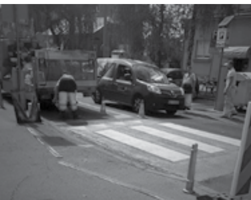
Postavljanje uspornika u Trakošćanskoj 1
